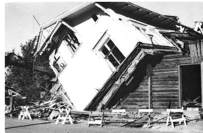
Riving av Liegaten 15 1976 under ett tilsynelatende sveitserbygg finner vi en tømmerkjerne. Foto fra boken Bymiljøer fra i går til i dag, trekk fra utviklingen i Skien og Porsgrunn etter 1945 (1980) av Tor Kjetil Gardåsen
