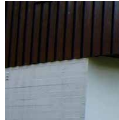
Oppbrutte flater. Kombinasjon av tre og tegl.
