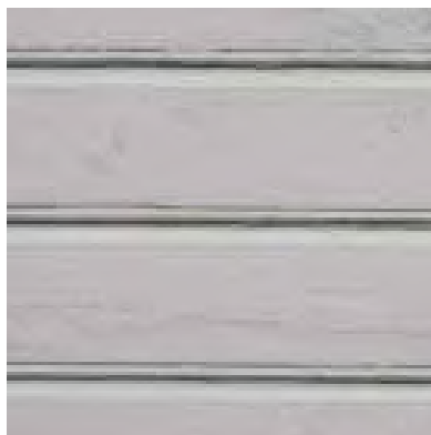
Staffpanel var vanlig, både liggende og stående, og enkelte ganger en kombinasjon.
