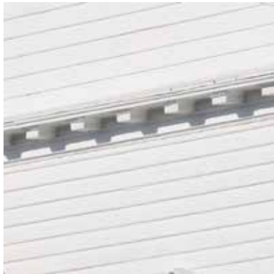
Staff-/veksel-/falset panel. Enkle lister. Brede hjørnekasser.
