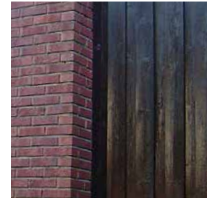
Kombinasjon av tre og tegl.
