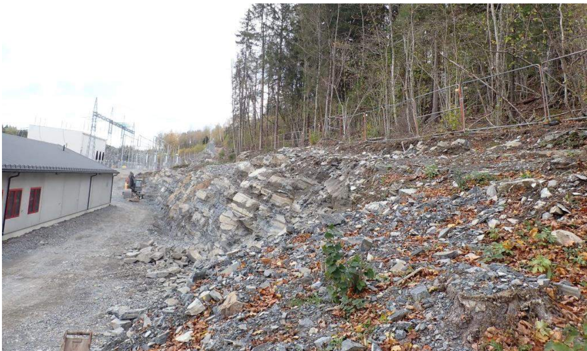
Figur 4-16. Svært negative inngrep i kalkgranskog ved Rød transformatorstasjon. Et mer arealminimerende prinsipp med verdifullt naturmangfold som premiss burde vært lagt til grunn her (foto: R. Solvang).
