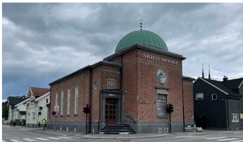
Hesselbergsgate 12 er et eksempel på enkeltbygg med særlig forseggjort utforming og detaljering, som har høyere kulturhistorisk verdi enn delområdets samlede verdi.
