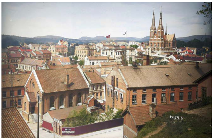
Skien Margarinfabrikk ca 1900. Kilde: Skien kommune
