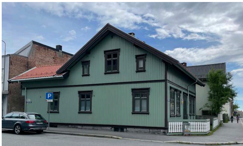
Eksempel på verneverdig bygg i Skien, Holbergs gate 13.
