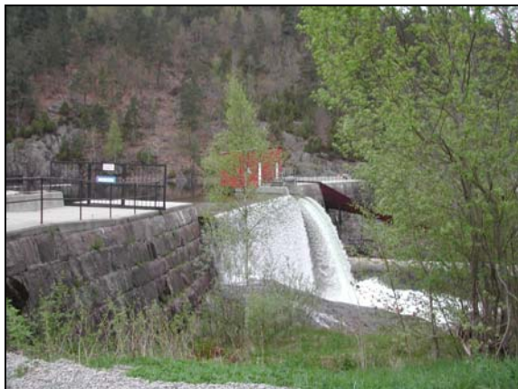
Kongens dam i Bamble demmer opp Hellestvedtvannet
