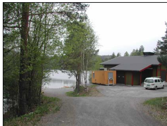
Vannverket for Bamble kommune ligger ved Flåte.
