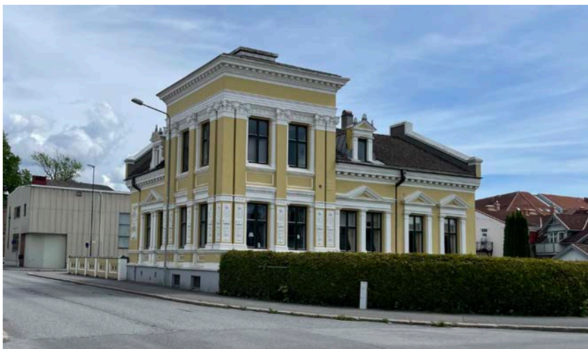
Innenfor analyseområdet ligger det flere enkeltbygg med særlig forseggjort utforming og detaljering, som har høyere kulturhistorisk verdi enn delområdenes samlede verdi. Disse er definert som særlig viktige bygg i analysekartene. Her "Håndverkeren", Cort Adellers gate 1.
