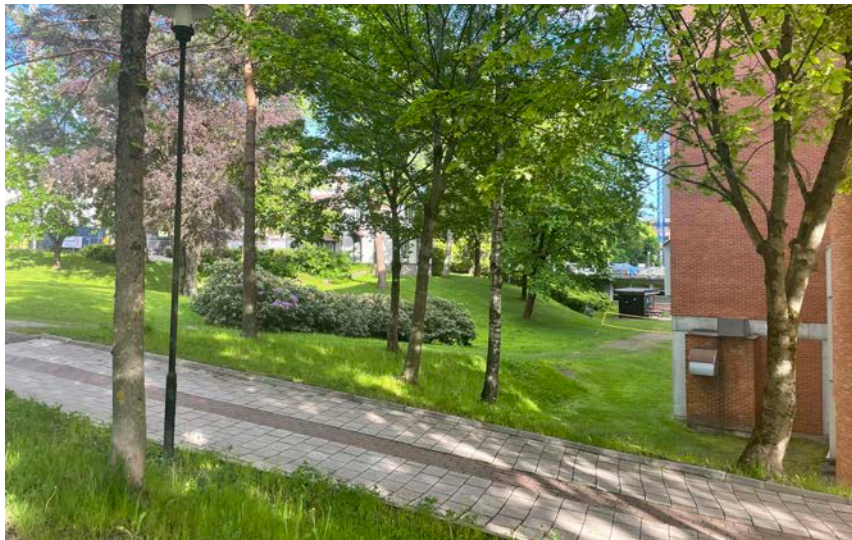
Store teglbygg på parkmessige opparbeidete tomter i Kverndalen.
