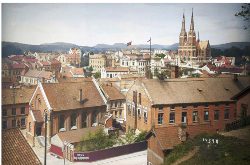
Skien's Margarinfabrikk ca 1900. Kilde: Skien kommune
