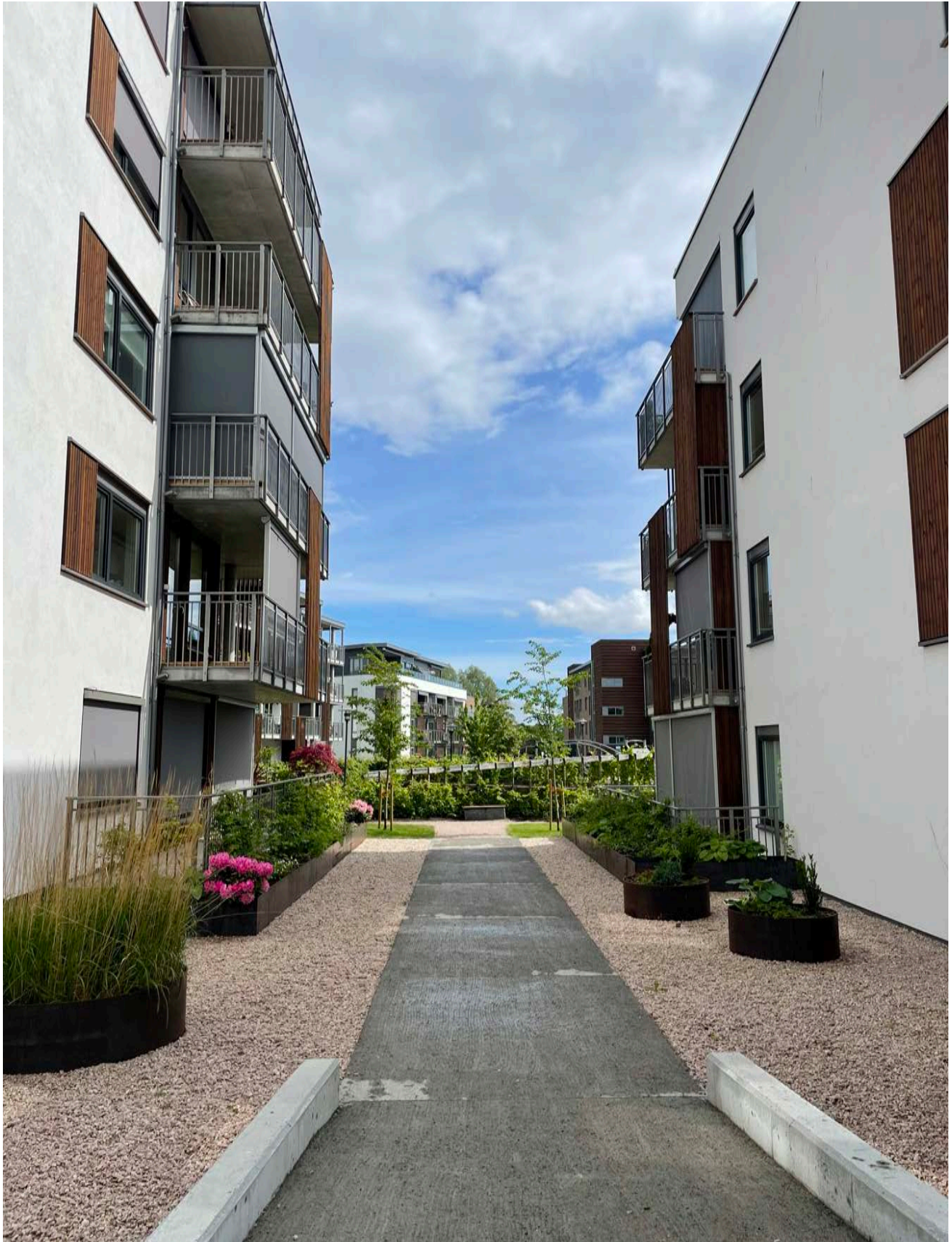
Bygningstiljø innenfor tålegrense D. Fløtningen på Bakken.
