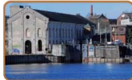
opprustning av sluse og kanal
