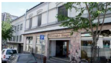
Eksempel på ny materialbruk i det historiske sentrums første etasje
