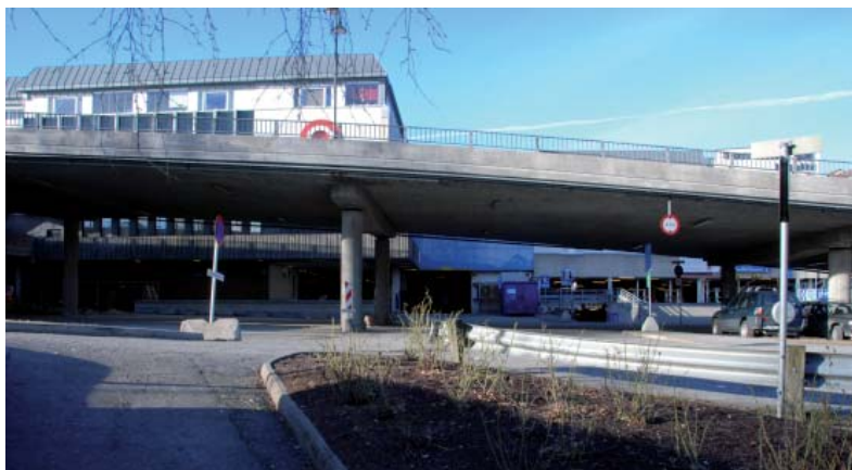
Møllebrua og arealene under – en barriere mellom handelssentrum og vannet.
