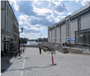
Henrik Ibsensgate, bylivet har forsvunnet inn bak fasaden
